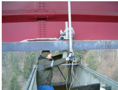
Bild 15: Visuelle Überprüfung der Nahtdicke mittels Laserscan
