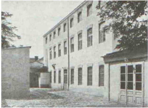
Bild 1: Hof mit Bürotrakt der Schweißtechnischen Lehr- und Versuchsanstalt in Wien
